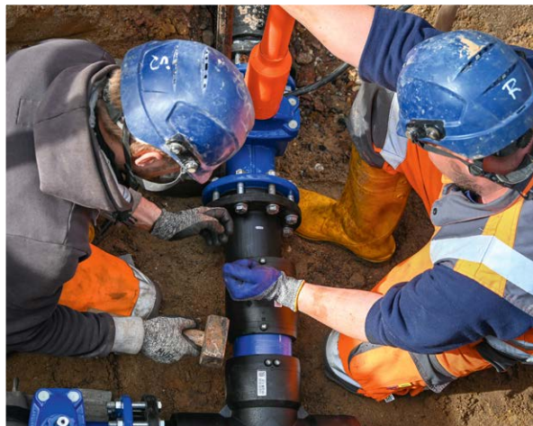
Die MIDEWA-Monteure Patrick Reh (re.) und Sten Micklisch bauen die neuen Schieberkreuze am Markeschen Platz in Raguhn ein.
