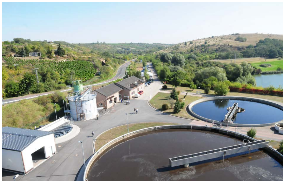
Kläranlage Rollsdorf: Hier wird das Abwasser aus dem Entsorgungsgebiet des AZV Eisleben – Süßer See umweltgerecht behandelt. Eine Aufgabe für die MIDEWA als Betriebsführer.
