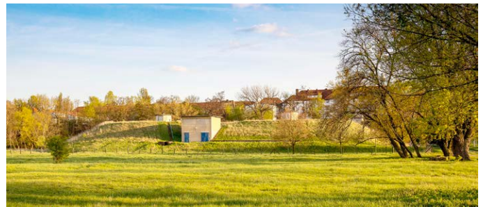
Der Hochbehälter Rössen muss instandgesetzt werden.
