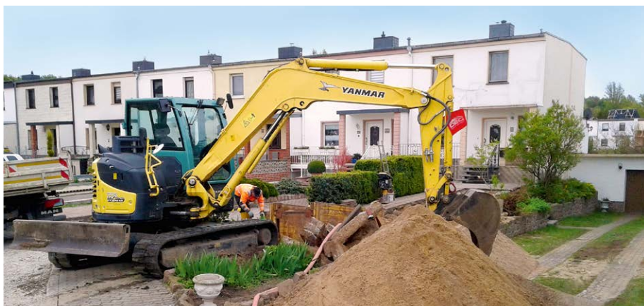
Baumaßnahme im Gröbzigter Reihenhausring: Die Versorgungsleitung war durch mehrere Rohrbrüche auffällig geworden. Nun wird sie erneuert, während die Stadt die Straße neu baut.
