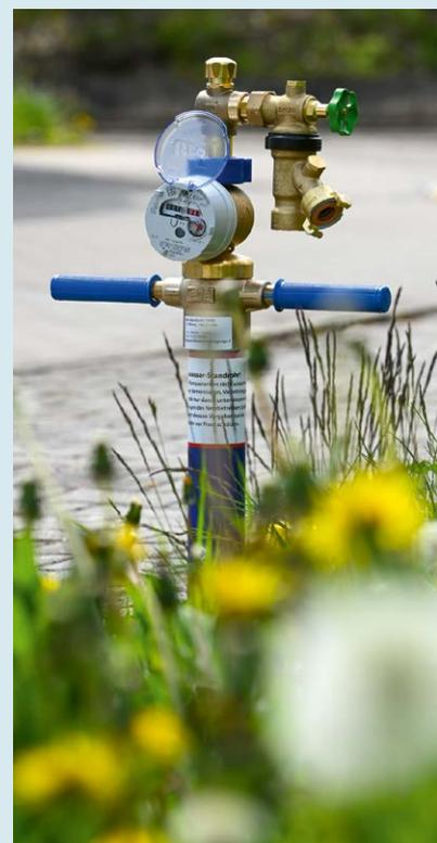
Mit einem Standrohr kann eine Verbindung zum öffentlichen Trinkwassernetz hergestellt werden.
