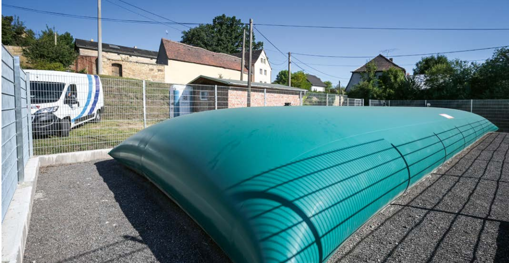
Sieht aus wie ein übergroßes Luftkissen: die faltbare Löschwasserzisterne der MIDEWA.
