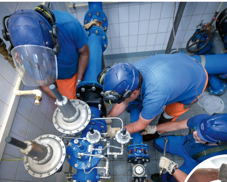
MIDEWA-Teamwork (Foto links): Mit dem Einbau eines Druckregelventils der neuesten Generation im Hochbehälter (Foto oben) konnte der Wasserdruck stabilisiert werden.
