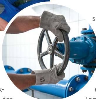
MIDEWA-Teamwork (Foto links): Mit dem Einbau eines Druckregelventils der neuesten Generation im Hochbehälter (Foto oben) konnte der Wasserdruck stabilisiert werden.
