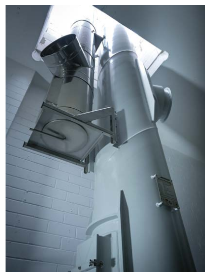
Um den 16 Meter hohen Schornstein zunächst an seinem Standort zu postieren, war Präzisionsarbeit über eine Dachluke gefragt.
