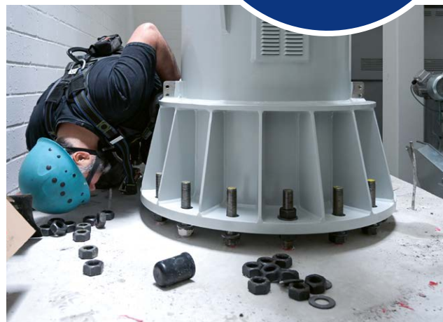
Maximaler Halt: Der neue Schornstein wurde mit dem Betonsockel gut verschraubt (Foto oben).
